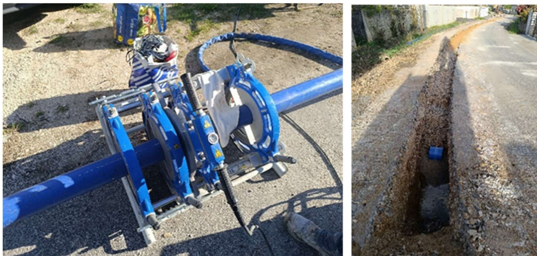
Imagem 51: Pormenor de soldadura topo a topo e implantação da conduta
