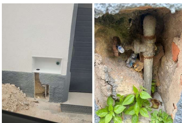
Imagem 39: Exemplo de renovação de ramal
