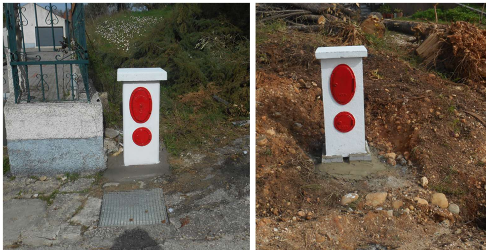
Imagem 43: Reabilitação de marcos de bocas de incêndio
