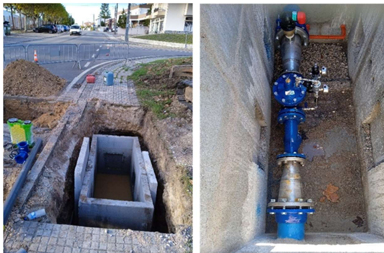
Imagem 50: Intervenção no subsolo e equipamento instalado
