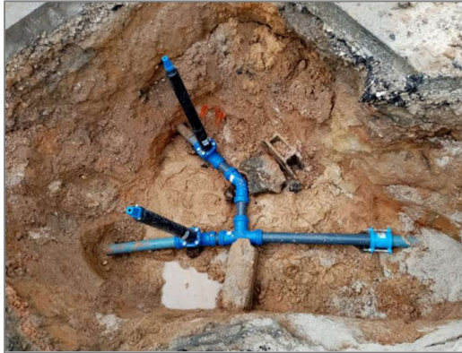
Imagem 41: Substituição/ renovação de válvulas de seccionamento
