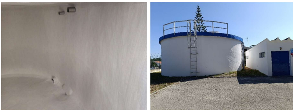
Imagem 45: Reservatório após intervenção
