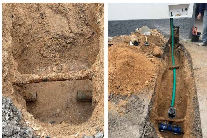
Imagem 40: Exemplo de renovação de ramal
