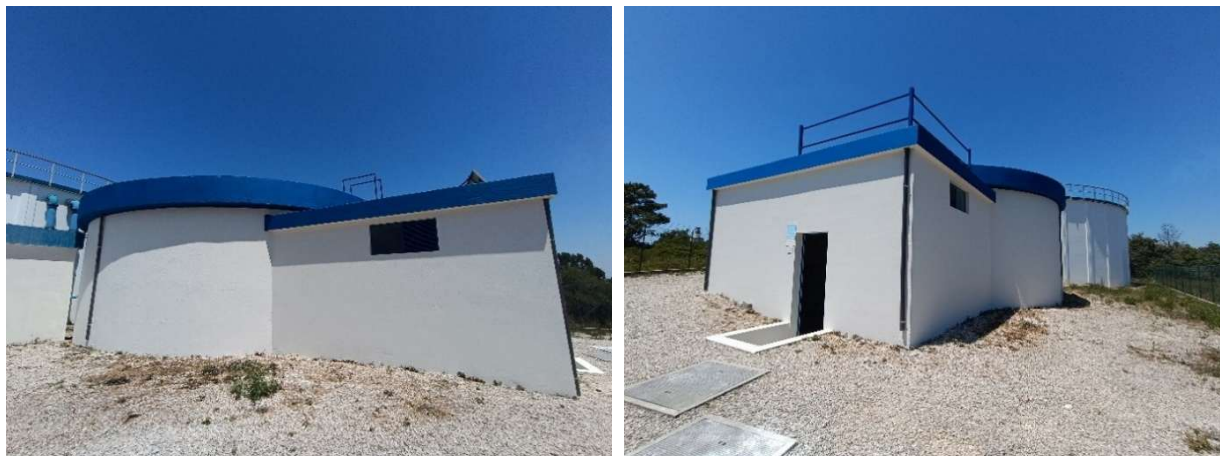
Imagem 44: Reservatório após intervenção
