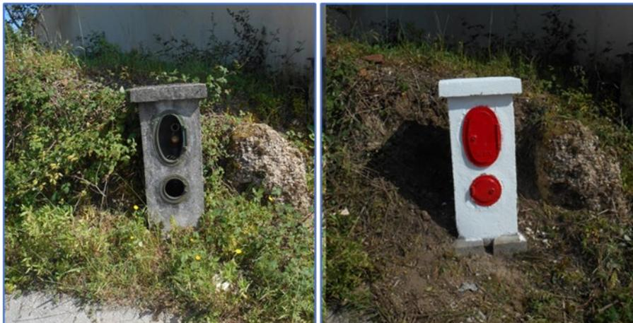
Figura 38: Reabilitação de marcos de bocas de incêndio
