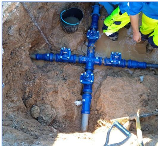
**Figura 36:** Substituição/ renovação de válvulas de seccionamento
