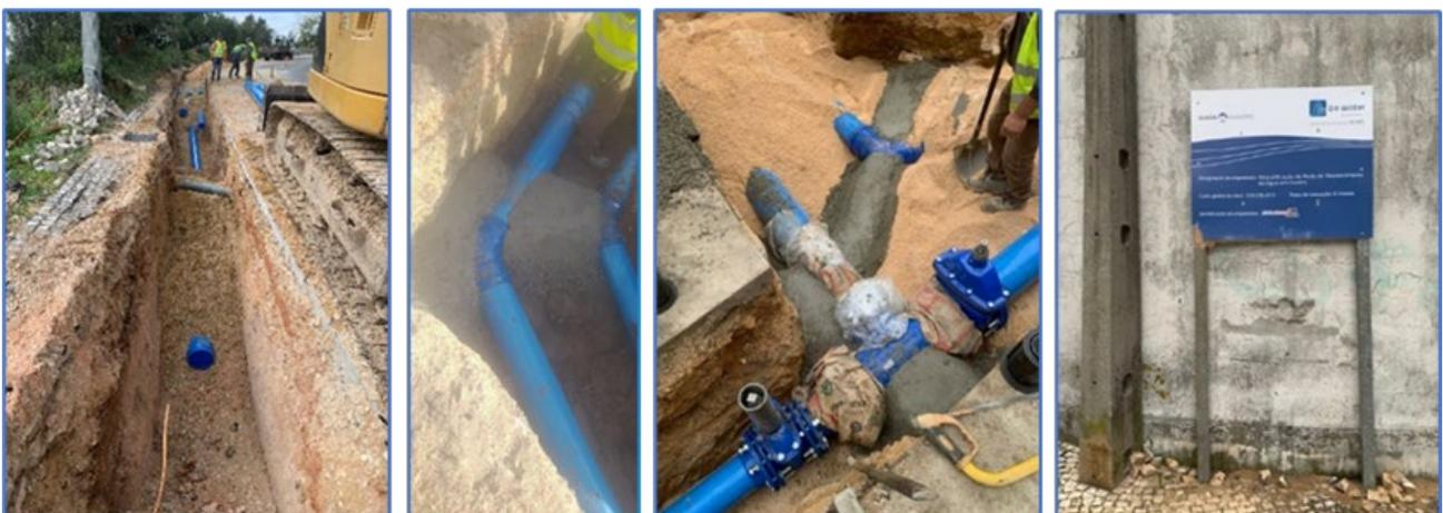
**Figura 48:** Condutas, acessórios e placa da empreitada
