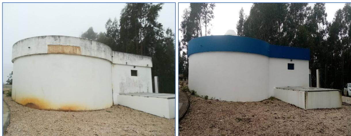
**Figura 42:** Reservatório do Estreito, antes e após intervenção
