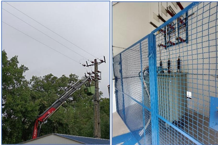
**Figura 45:** Operação de substituição do transformador na Carapita (esq.) e transformador após intervenção na Caridade (dir.).
